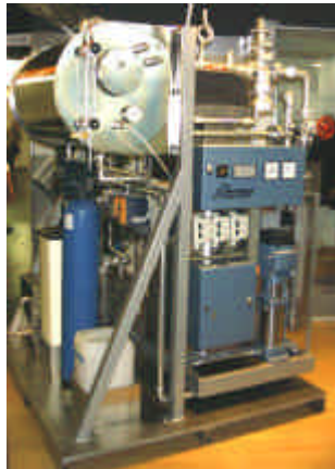
Jumag steam generator complete unit Steam generating capacity 360 kg/h Textilaufbereitung Surauer, München
